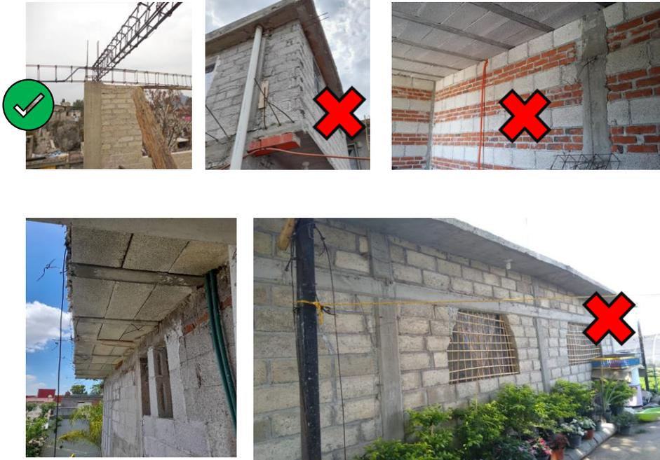
**¡Aguas! En las losas marinas debes colocar una cadena de cerramiento para amarrar la losa.**
