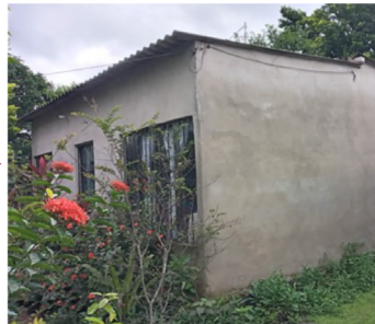
VIVIENDA EN PROCESO
